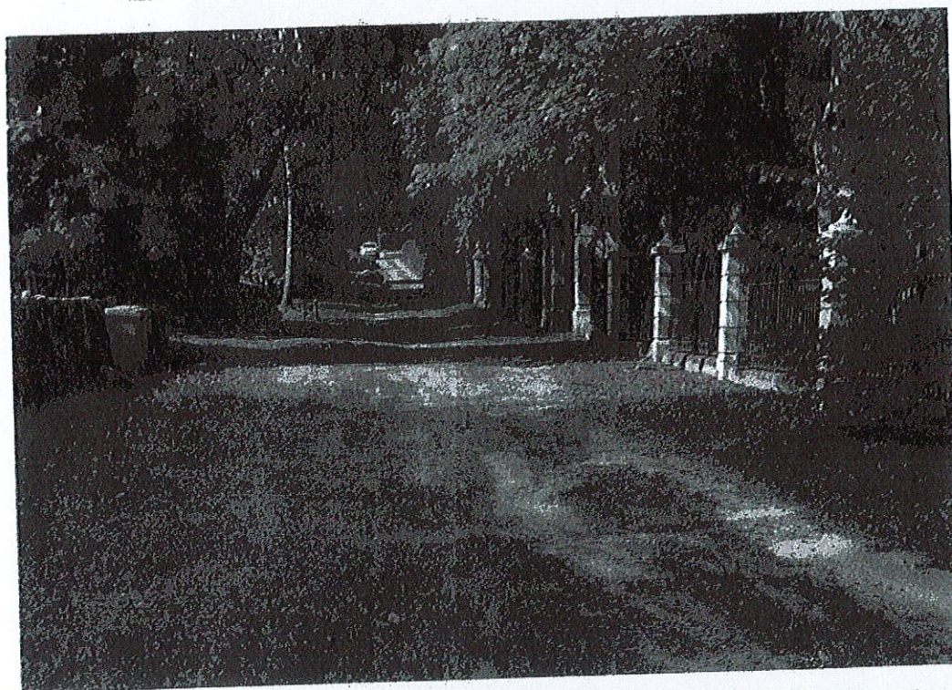
Widok z miejsca w którym powinna być końcowa studnia kanalizacyjna w kierunku przebudowanej drogi powiatowej
